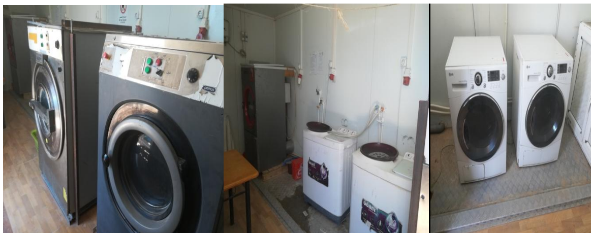
Photo II.6 : Une buanderie d'un chantier [Photo prise le 13/04/19]
