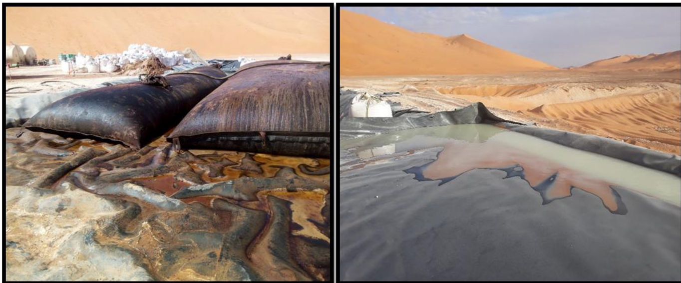
Photo III.6 : Géo-tube sur chantier [3]
