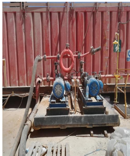
Photo III.5 Débitmètre photo III.6 pompe transfert [Photo prise le 02/03/19]
