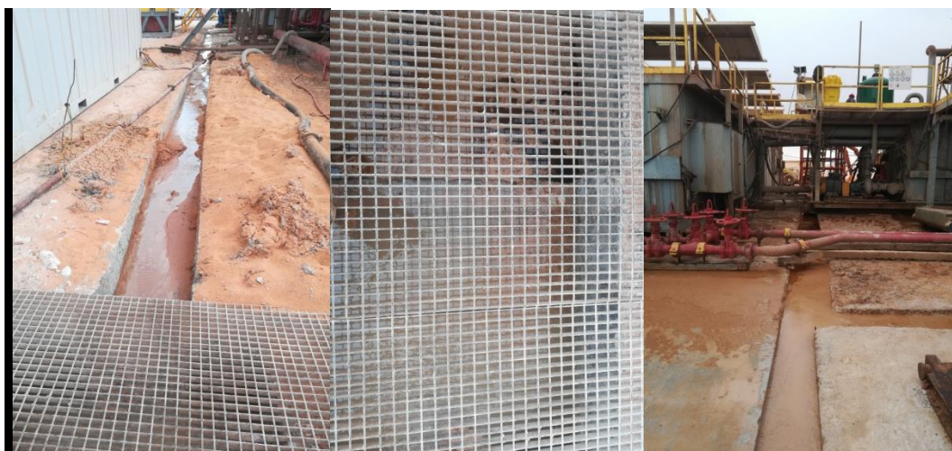
PhotoIII.1 : Les rigoles de collection des eaux [Photo prise le 24/02/19]
