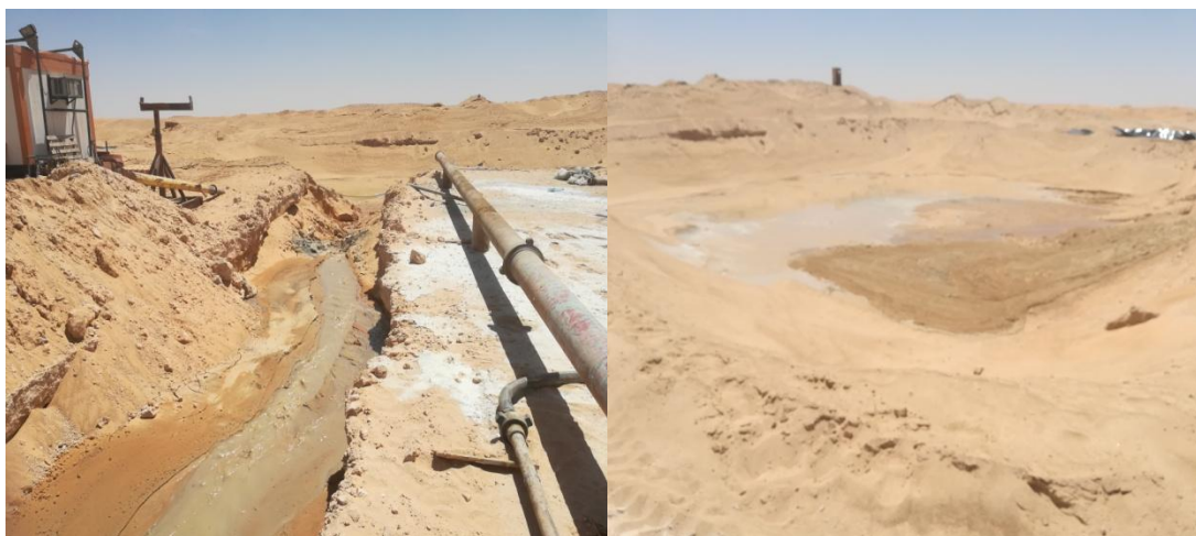
Photo 1 : Les déblais de forage dans la phase WBM [Photo prise le 15/04/19]
