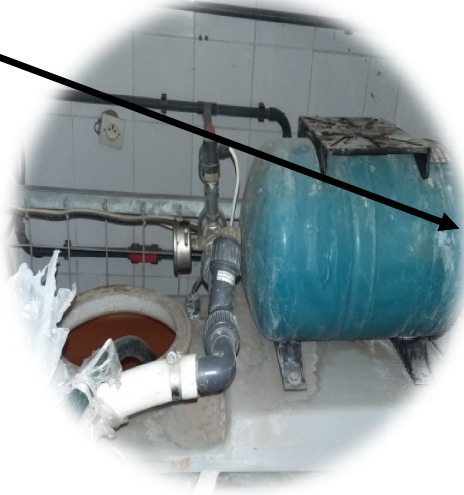
Figure (III.6) : « La cuve de stockage » Figure (III.7) : « La pompe de captage »
