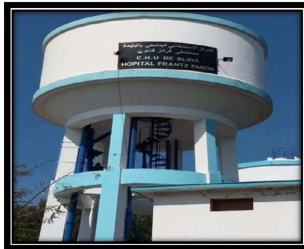
Figure (III.4): « Château d'eau de l'hôpital Frantz fanon ».
