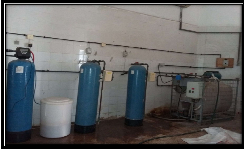
Figure (III.5) : « La chaîne de traitement d'eau destinée à l'hémodialyse ».
