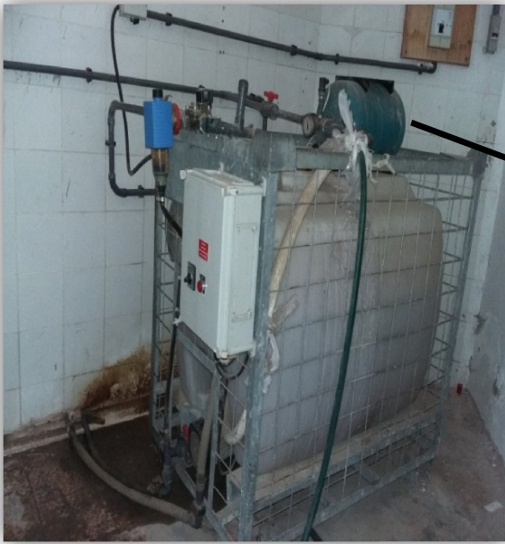
Figure (III.6) : « La cuve de stockage » Figure (III.7) : « La pompe de captage »
