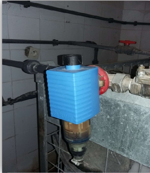
Figure (III.8): « Filtre à cartouche 100 \mu\text{m} ».
