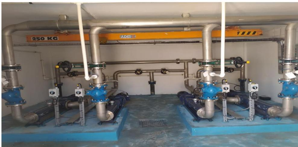
Figure 3.16. Les pompes centrifuges des boues en excès
