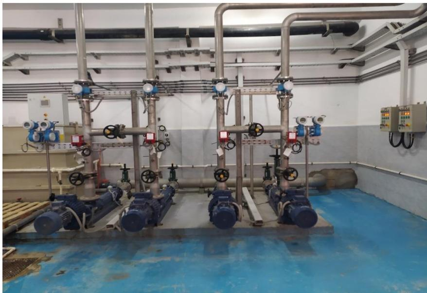
Figure 3.20. Les pompes dédiées pour l'injection du polymère
