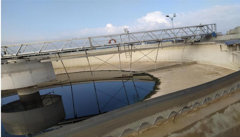
**Figure 3.8.** Décanteur primaire vide montrant la lame inoxydable, la trémie, et les racles de surface.
