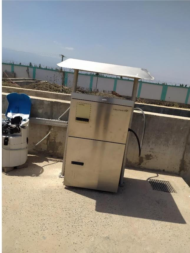
**Figure 4.2.** Releveur automatique de la sortie de la step de Boufarik
