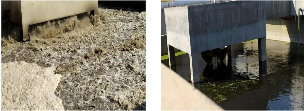
**Figure 3.9.** Turbine de surface du bassin d'aération en état stable et en marche
