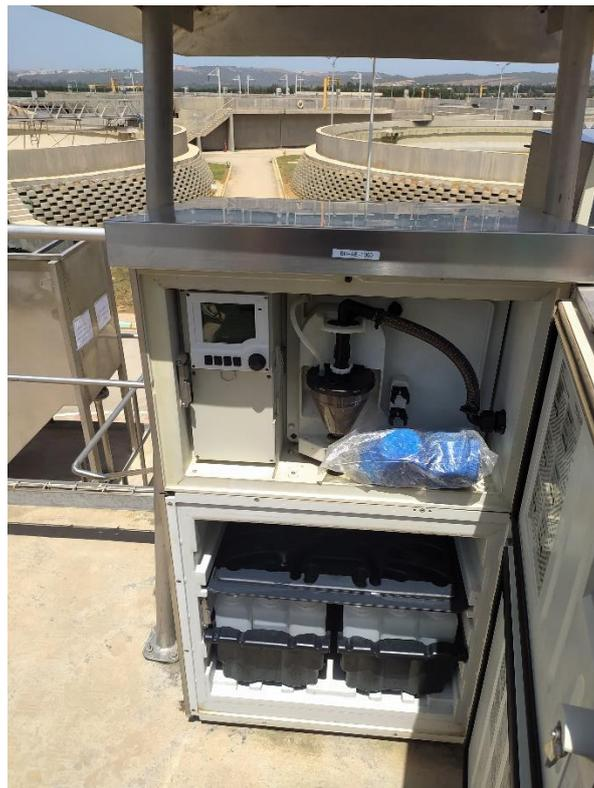
**Figure 4.1.** Releveur automatique du prétraitement de la step de Boufarik
