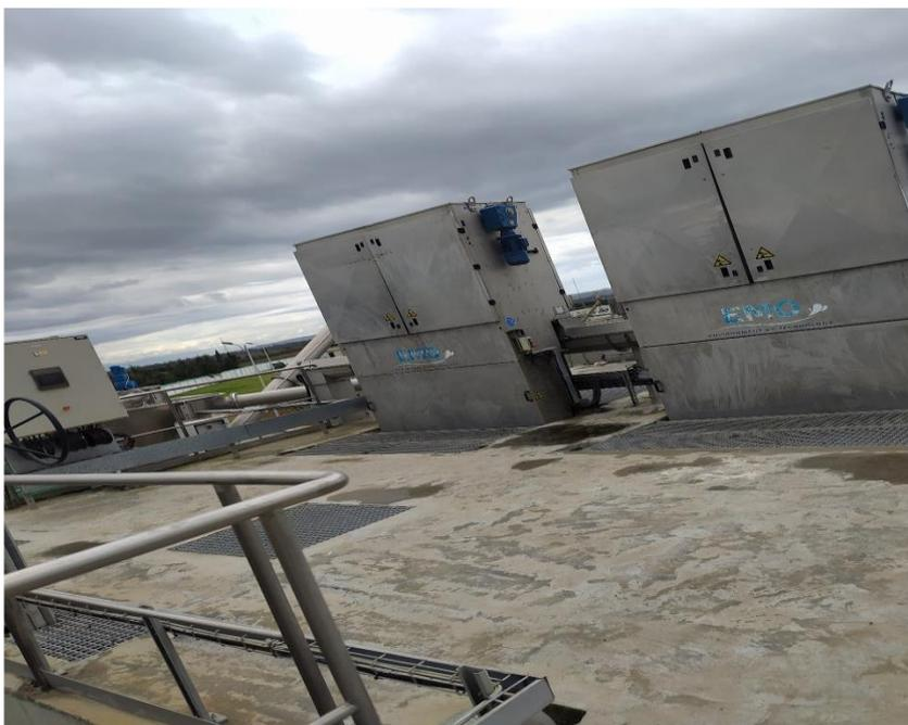
**Figure 2.3 :** Dégrilleur fin du step de Boufarik
