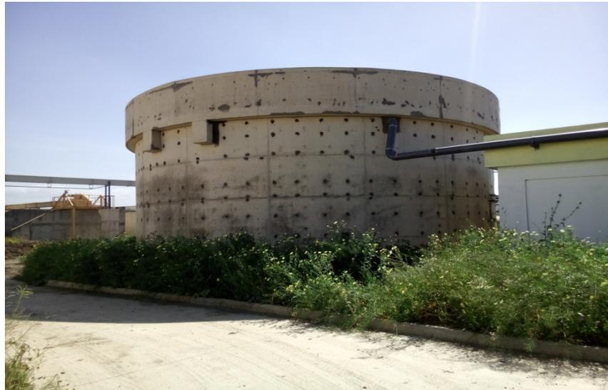
**Figure III.21:** Pré-épaississeur(photo prise sur terrain Mars 2017).
