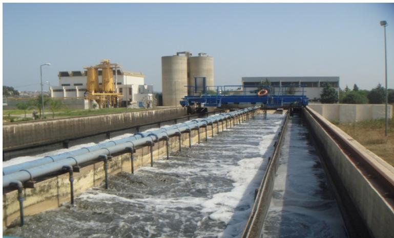
**Figure III.14:** Dessableur déshuileur(photo prise sur terrain Mars 2017).
