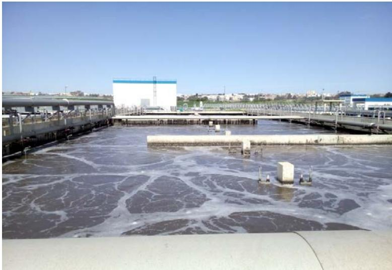
**Figure III.16:** Bassin biologique ou d'aération (photo prise sur terrain Mars 2017).
