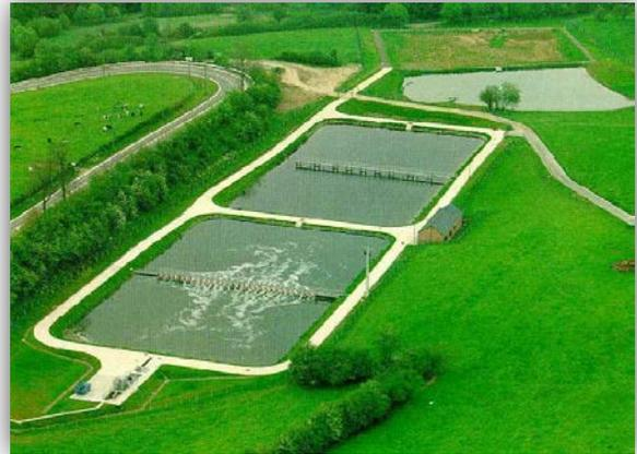
**Figure I.6:** Le lagunage aéré [16].
