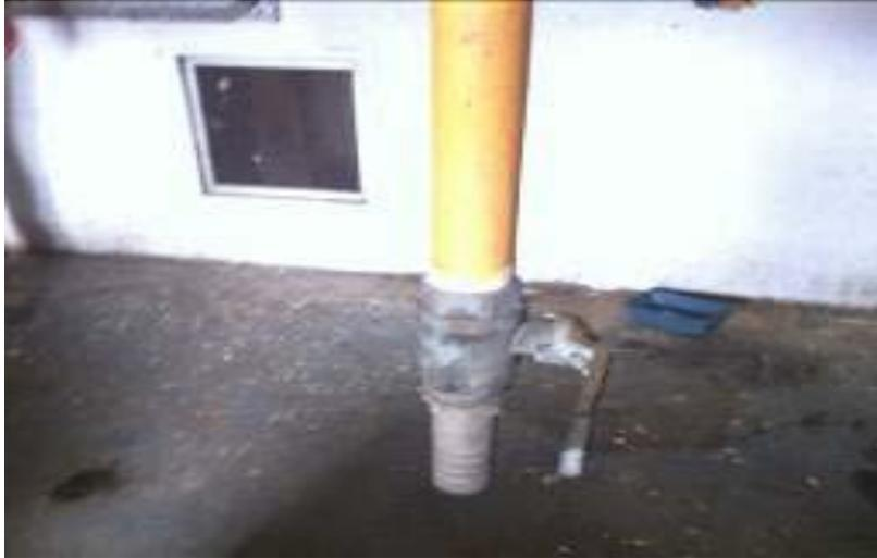
**Figure n° 11:** Point de prélèvement des boues digérées.
