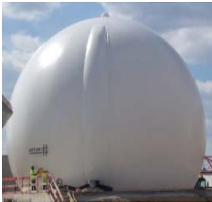
**Figure III.28:** Gazomètre souple.
