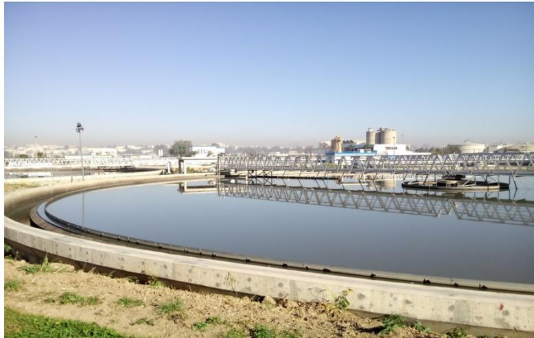
**Figure III.15:** Décanteur primaire (Décantation primaire) (photo prise sur terrain Mars 2017).
