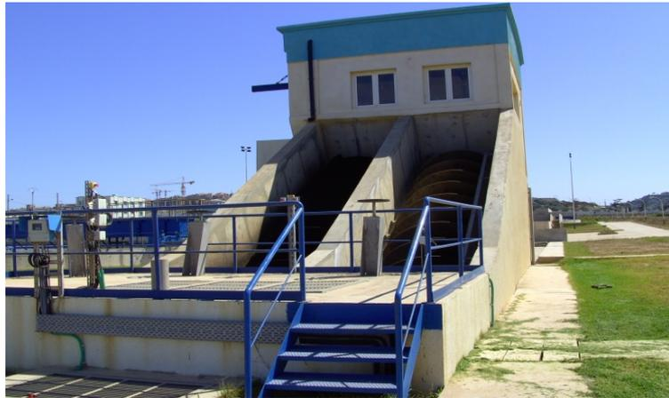
**Figure III.19:** Vis recirculation des boues(photo prise sur terrain Mars 2017).
