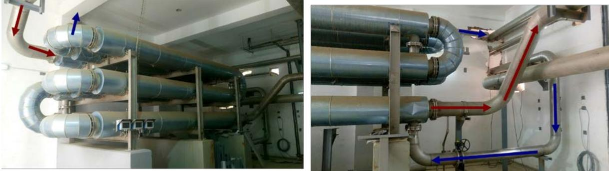
**Figure III.26:** Echangeur de chaleur de la STEP de BARAKI
