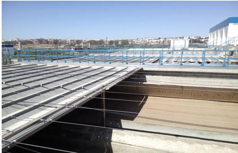
**Figure III.18:** Lit de sable (filtration par filtres Aquasures)
