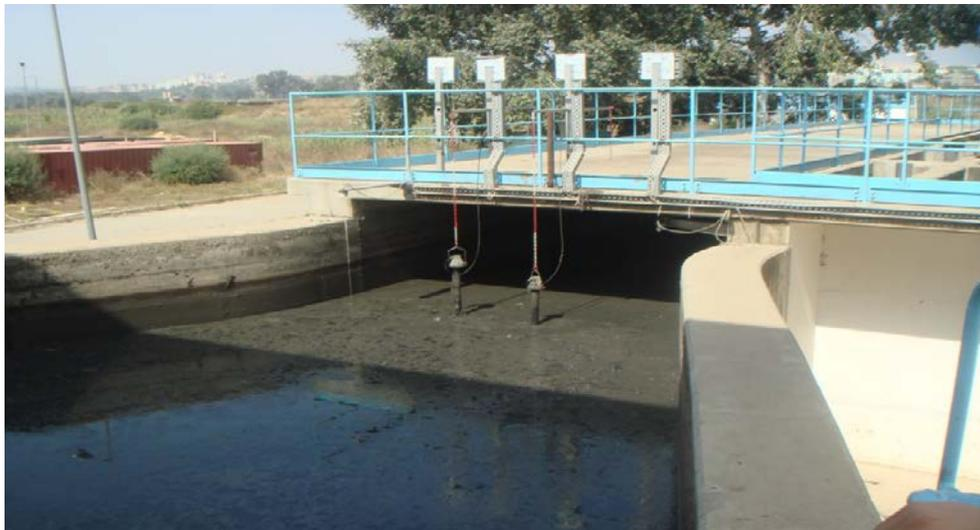
**Figure III.10:** Mesure de PH, la Température, la conductivité, et la teneur en hydrocarbures(photo prise sur terrain Mars 2017).
