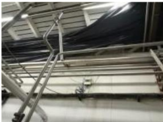
Figure 25 : Présence de bâche en plastique (Risque de contamination croisée). (Photographie originale)
