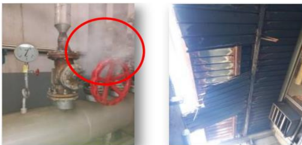
Figure 48 : Fuites de vapeur au niveau de la vanne d'envoi au niveau de local chaufferie. (Photographie originale)
