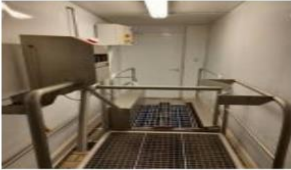
Figure 22 : Le SAS d’entrée siroperie est hors service. (Photographie originale)
