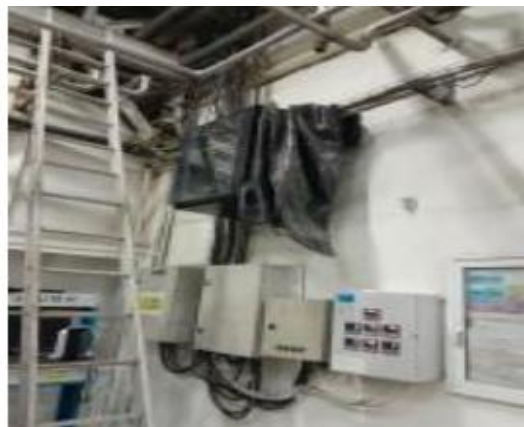
Figure 25 : Présence de bâche en plastique (Risque de contamination croisée). (Photographie originale)
