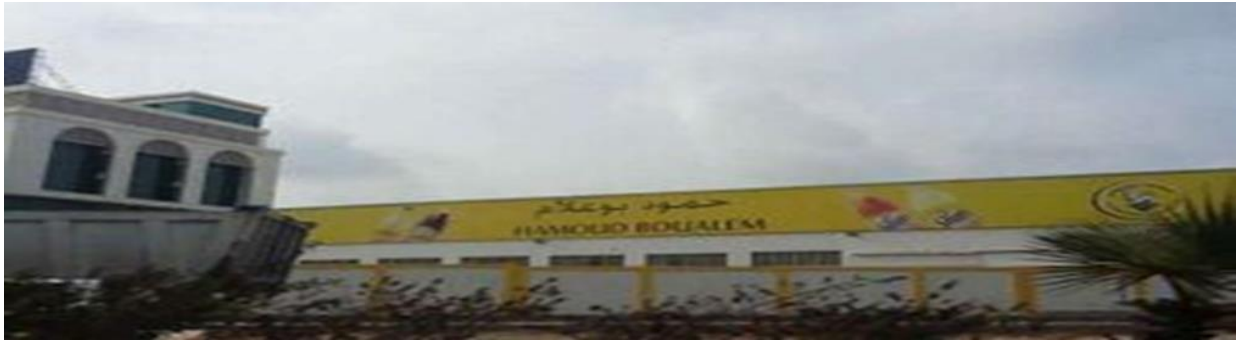
Figure 6: entreprise HAMOUD BOUALEM (BOUFARIK) [source HAMOUD BOUALEM ].
