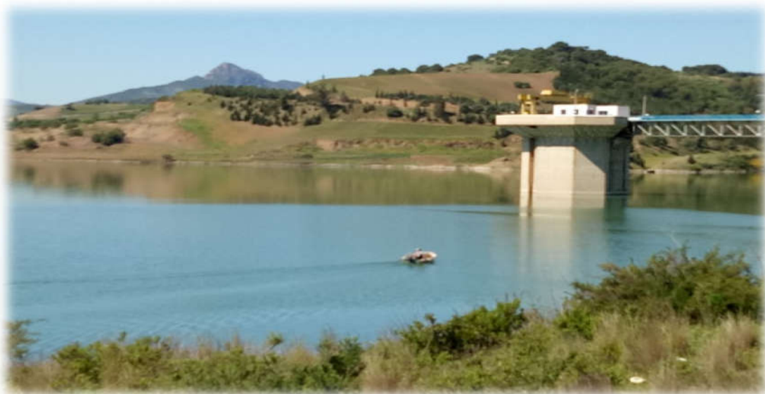
Figure 5 : Vue de la tour de prise du barrage de Boukourdane 2017 (prise pendant le stage).
