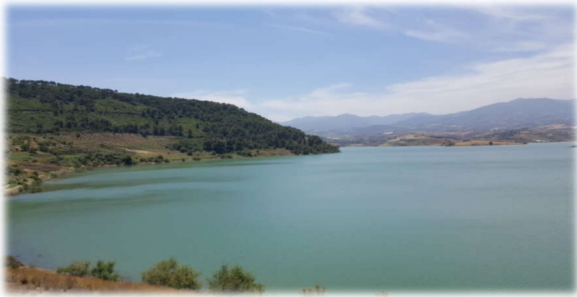
Figure 4 : Retenue du barrage de Boukourdane 2017 (prise pendant le stage) .
