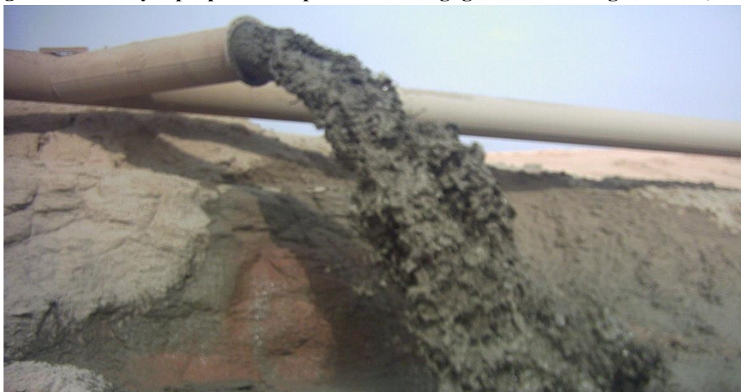
Fig.25 : Rejet de la vase lors de l'opération de dragage de 2005-2006(Remini,2006)
