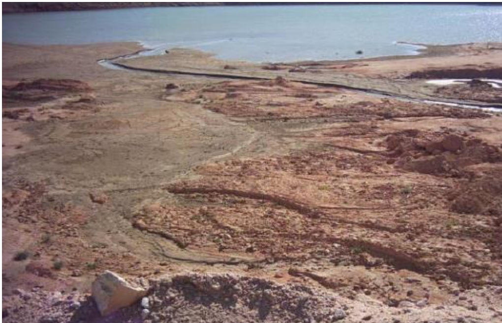
Fig.6: L'envasement dans la retenue du barrage de Foum El Gherza (Remini, 2006)
