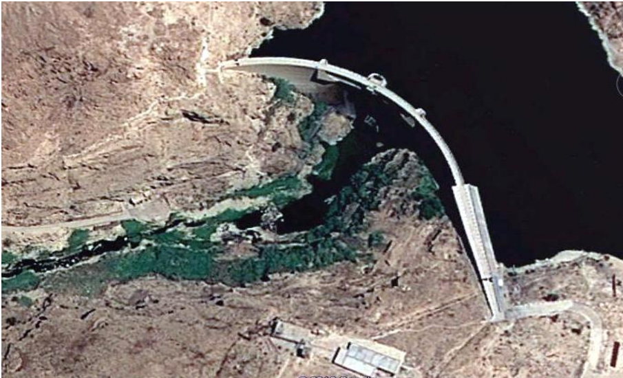
Fig.12: La vue du barrage de Foug El Gherza (Image prise de Google Earth)
