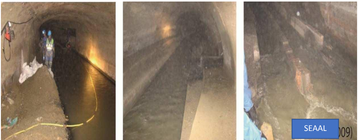
Figure V.2. Travaux de curages à l'intérieur du collecteur oued m'Kacel.
