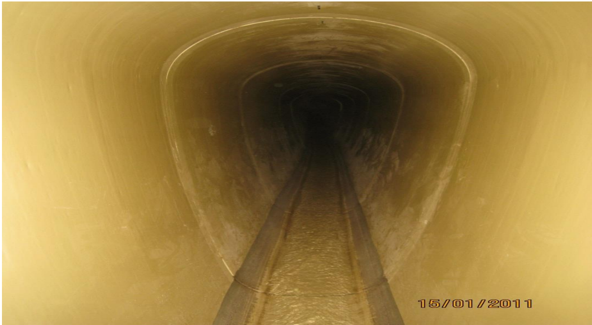
Figure 4. Le collecteur après réhabilitation en PRV.
