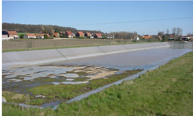
Figure IV 29 : Bassin de retenue
