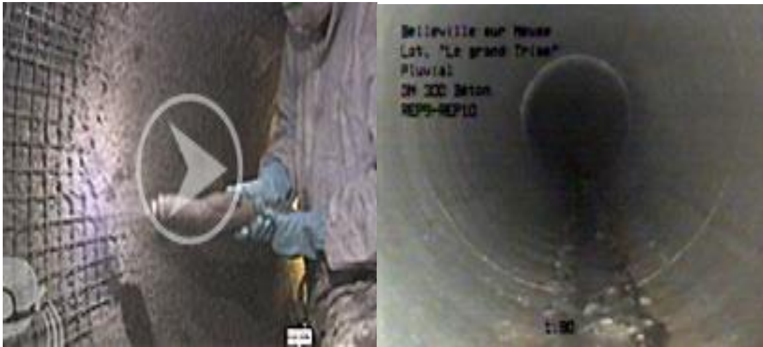
Figure.5. Réhabilitation en béton préacheté taloché.
