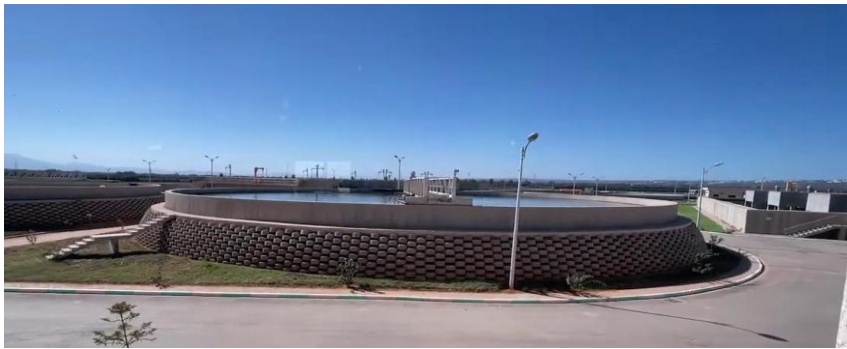
Figure 2.5 : décanteur primaire
