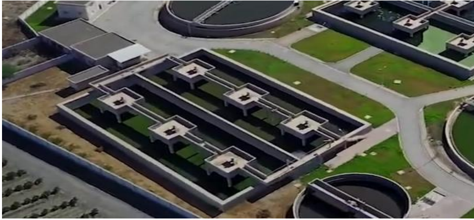
Figure 2.10 : Bassin de stabilisation aérobie, brassage par turbine (ONA, 2021)
