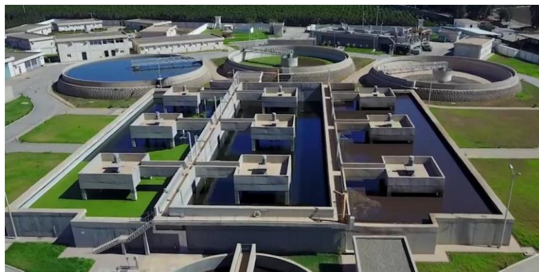
Figure 2.6 : Bassin d'aération rectangulaire de STEP Boufarik (ONA, 2021)
