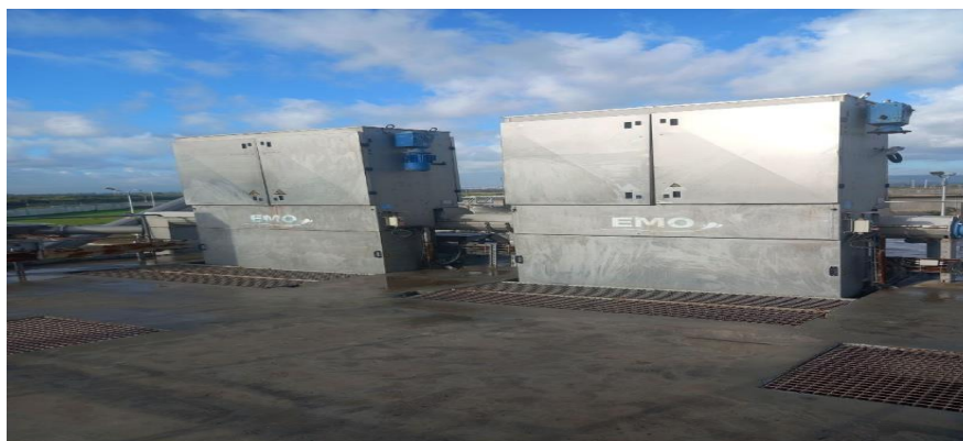
Figure 2.3 : Dégrilleur droit
