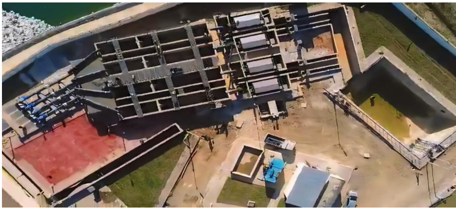
Figure 3.1 : traitement tertiaire de la STEP BOUFARIK (GROUPE, 2024)
