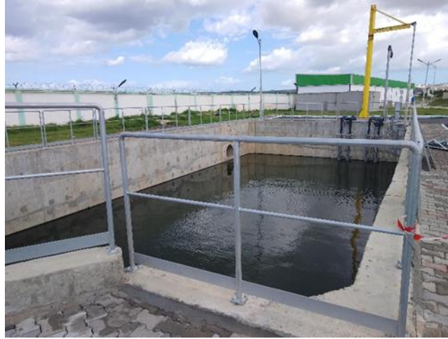
Figure 3.7 : Réservoir d'eau destiné à l'irrigation après traitement tertiaire
