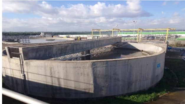
Figure 2.7 : Dégazeur de STEP Boufarik
