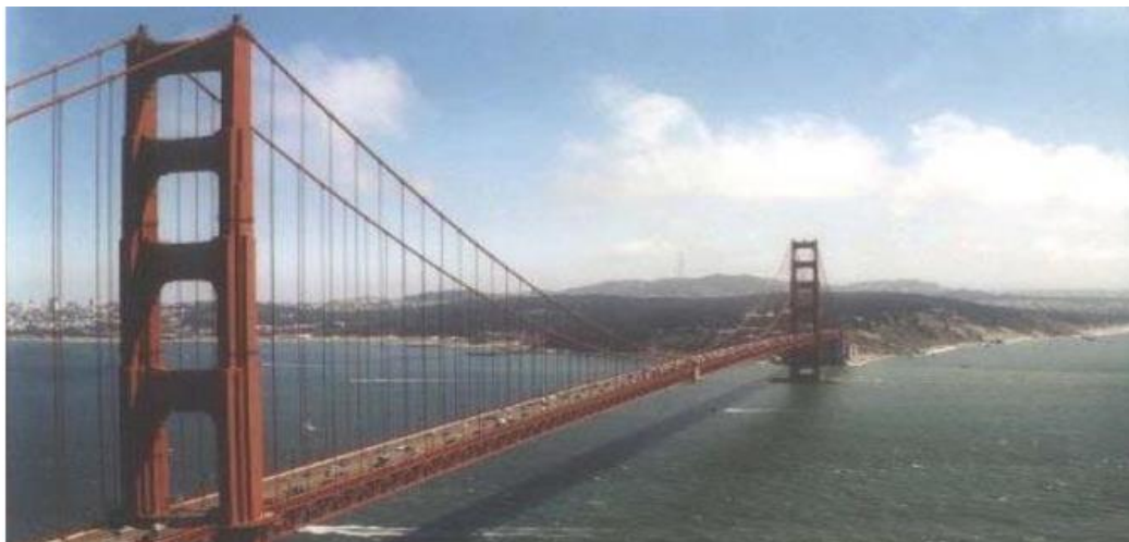
Figure 1.6 : Pont à câbles.
