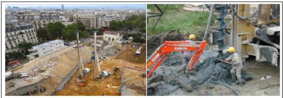
Figure 1.29 : Outils de forage à tarière creuse.
