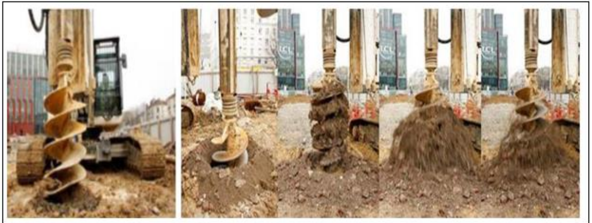
Figure 1.28 : Illustration d'une foreuse-foré simple.
