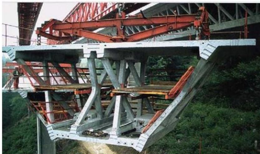
Figure 1.4 : Pont à caisson ou voussoir.
