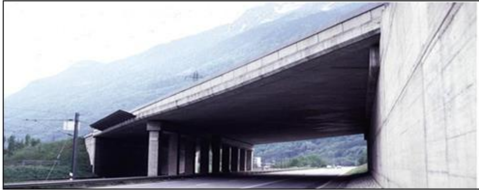
Figure 1.3 : Les ponts dalles.
