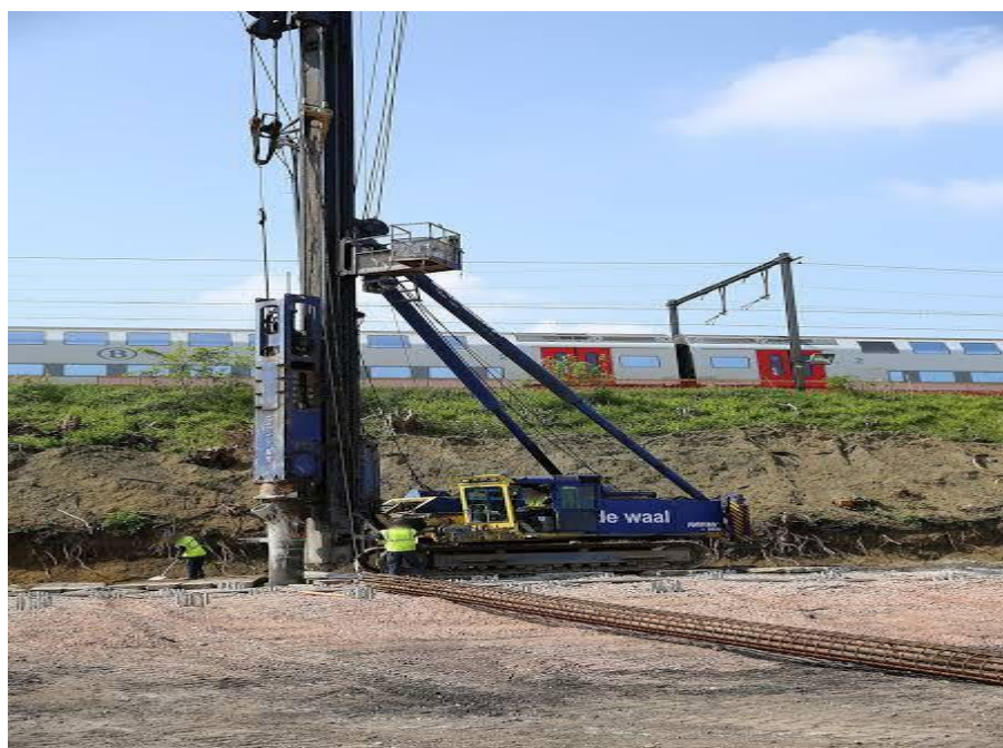
Figure 1.12 : Pieu battus moulés dans le sol.
