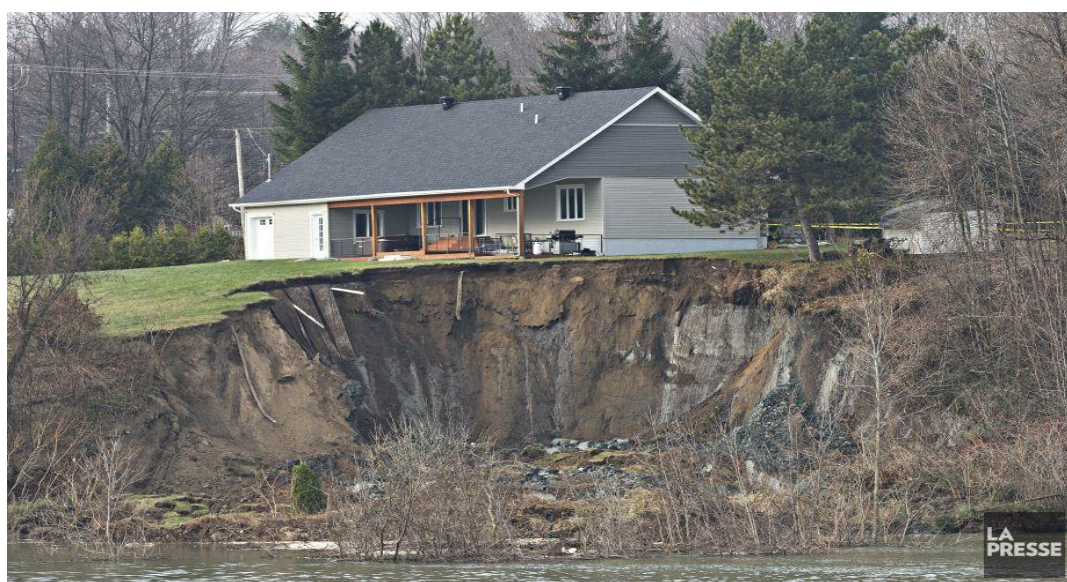
Figure1.1 : Exemple d'un glissement de terrain
