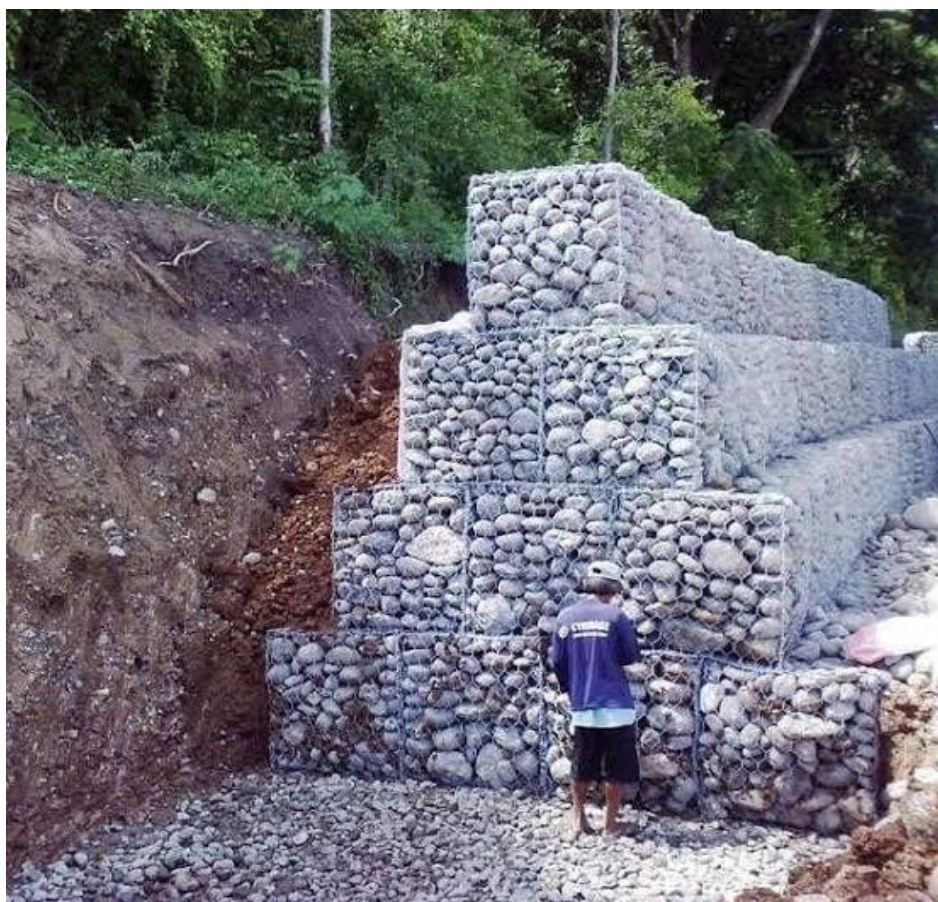
Figure 1.15: Conception de murs en gabions.
