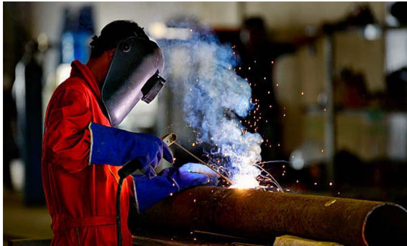
Figure I. 4: Le soudage en charpente métallique.
