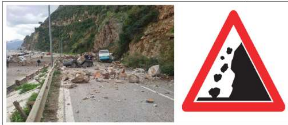
Figure I.7 : Éboulement ou chute de pierre à hauteur du tunnel éponyme sur le RN26 reliant Bejaia à Sétif. [5]
