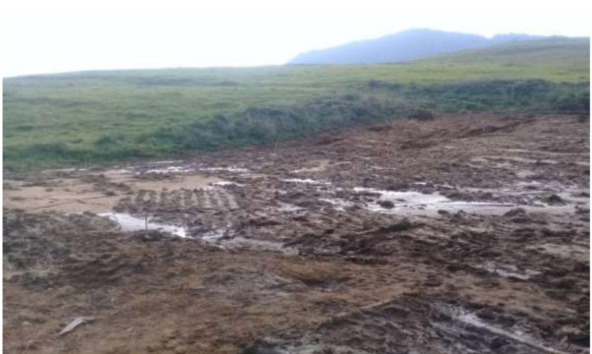
Figure II.4 : Talus de déblai caractérisé par des érosions intenses. Escarpement en tête de talus de déblai [29].
