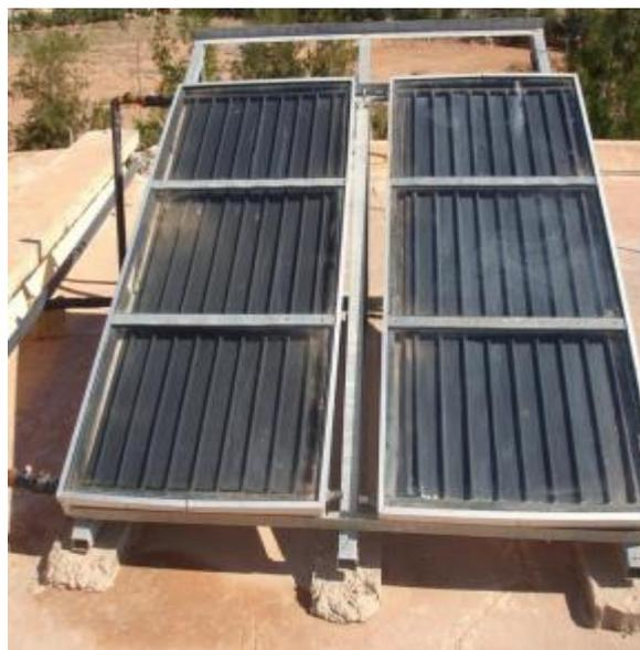
**Figure III.2 :** Capteur plan vitré. [53]
