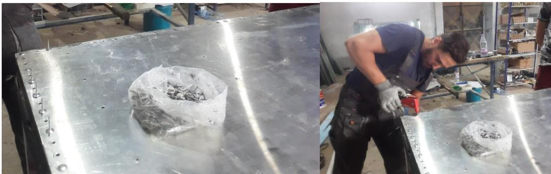
**Figure IV.10 :** rivetage du capteur (TH).
