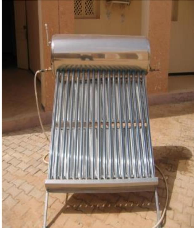
Figure III.4 : Capteur solaire à tube sous vide. [53]
