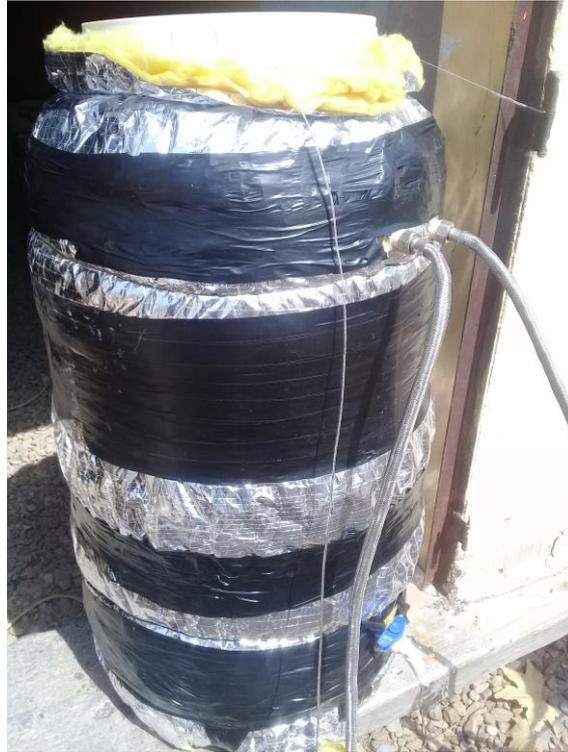
**Figure IV.14:** cuve de stockage avec échangeur avec isolation (laine de verre).
