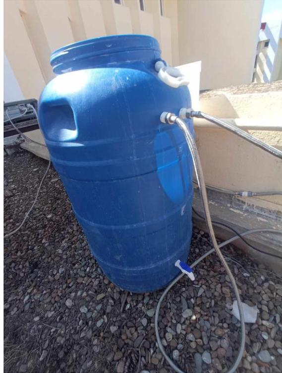
**Figure IV.13:** cuve de stockage avec échangeur sans isolation.
