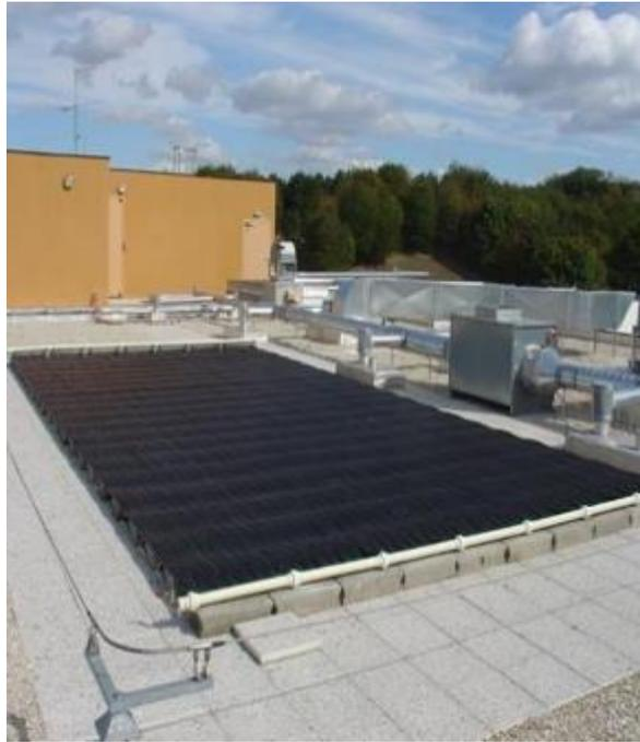
Figure III.3 : capteur solaire sans vitrage. [53]
