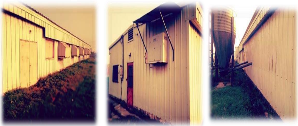
Figure 7 : Photographie du bâtiment d'essai (ITELV .2023).
