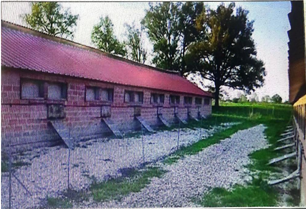
Figure 5 : Photographie de l'extérieur d'un bâtiment de pont plein-air (42)
