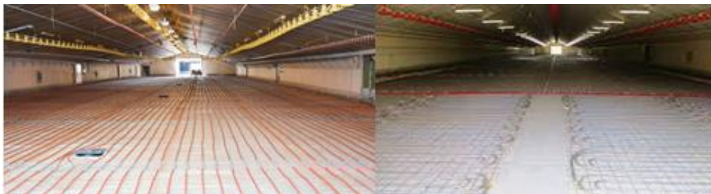
Figure 18: système de chauffage par le sol(38).
