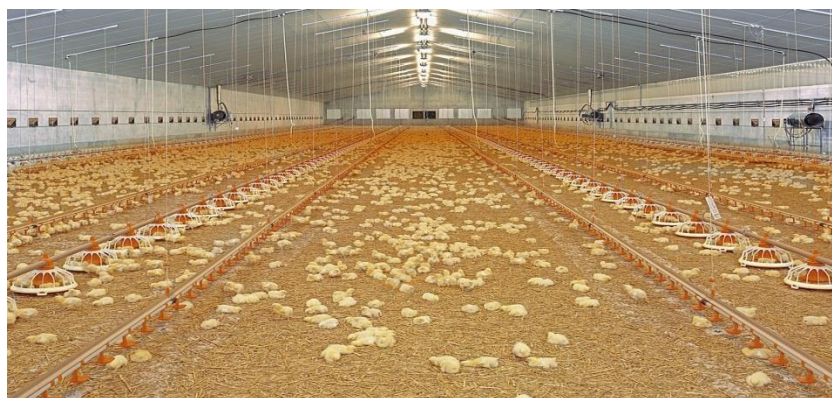
Figure 8: Démarrage sur toute la surface du bâtiment(28).
