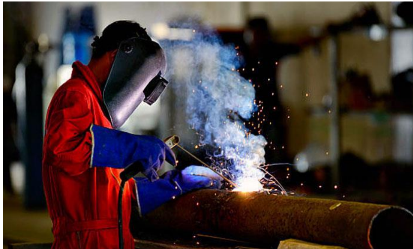
Figure I. 4: Le soudage en charpente métallique.
