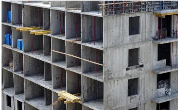
**Figure I.37** : Ossature contreventée par voiles en béton armé [42].
