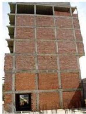
**Figure I.36** : Ossature contreventée par portique auto stable [1].
