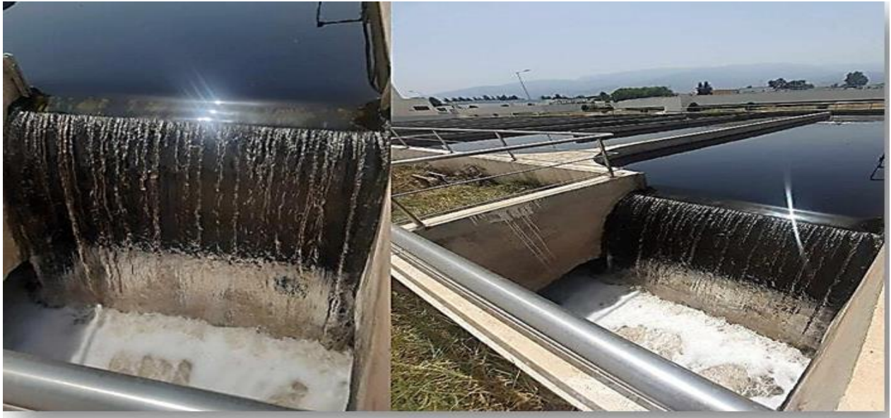
Figure 1. 6 Bassin de désinfection de STEP Beni Merad (Photo original 2024).
