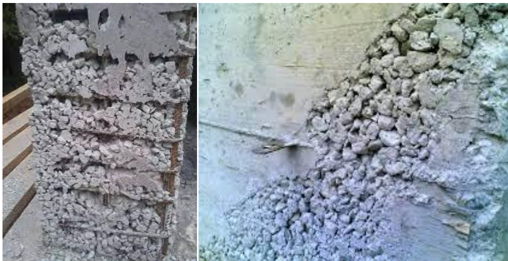
Figure I.4 : Ségrégation [3]
