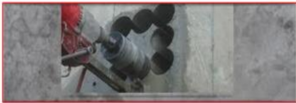
Figure I.6 : Prélèvement de carotte [5]
