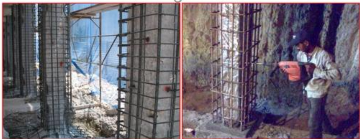
Figure I.7 : Les travaux de chemisage
