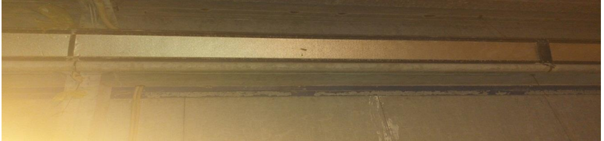
Figure 14: PAD COOLING en haut de la face latérale du bâtiment (photo perso, 2019)
