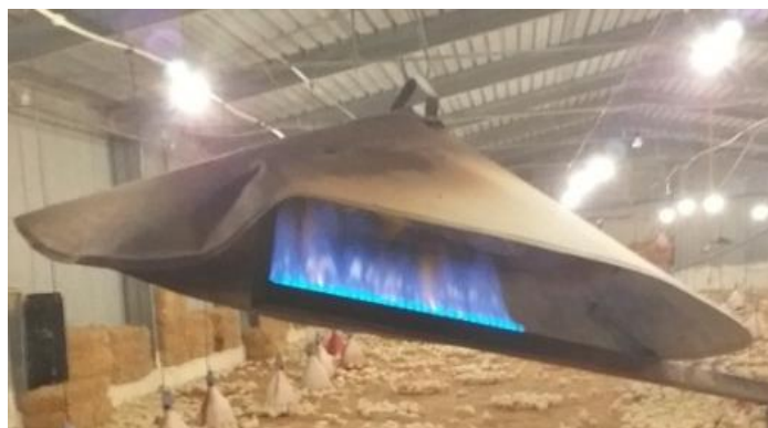
Figure 22 : éleveuse fonctionnant au gaz butane (photo perso, 2019)
