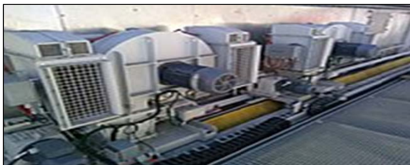
Figure 2-3 : Ventilateur basse pression sur chariot mobile pour le décolmatage des manches.
