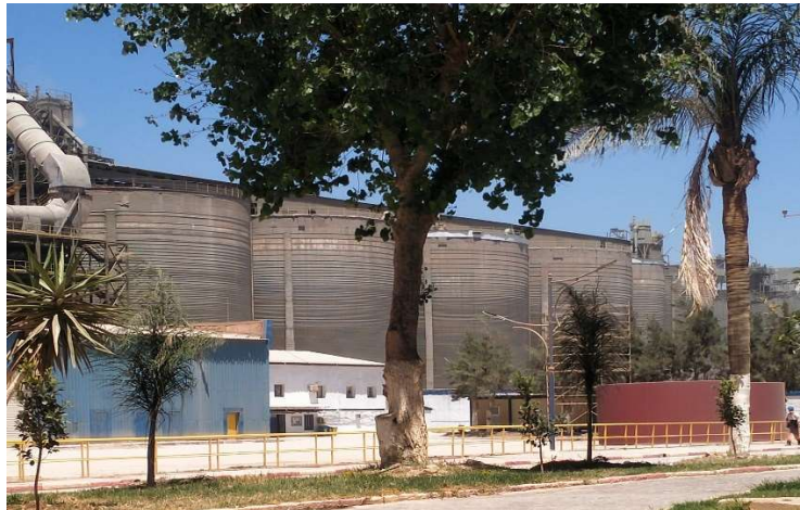
Figure 1-19 : Silos de stockage du gypse, calcaire et ciment.
