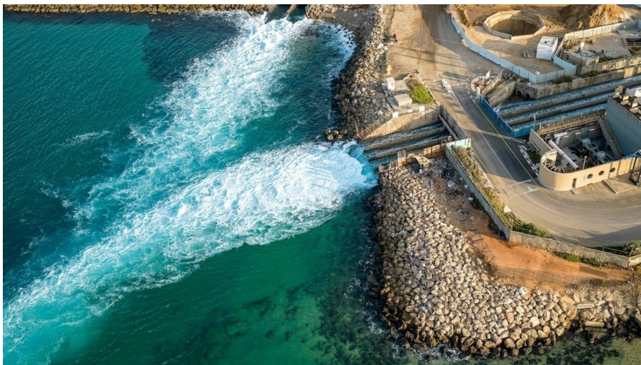
Figure I. 3: Station de dessalement des eaux de mer
