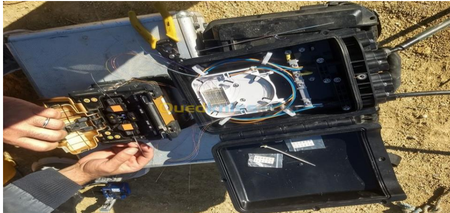
Figure I.18 : Raccordement par fusion sur terrain.
