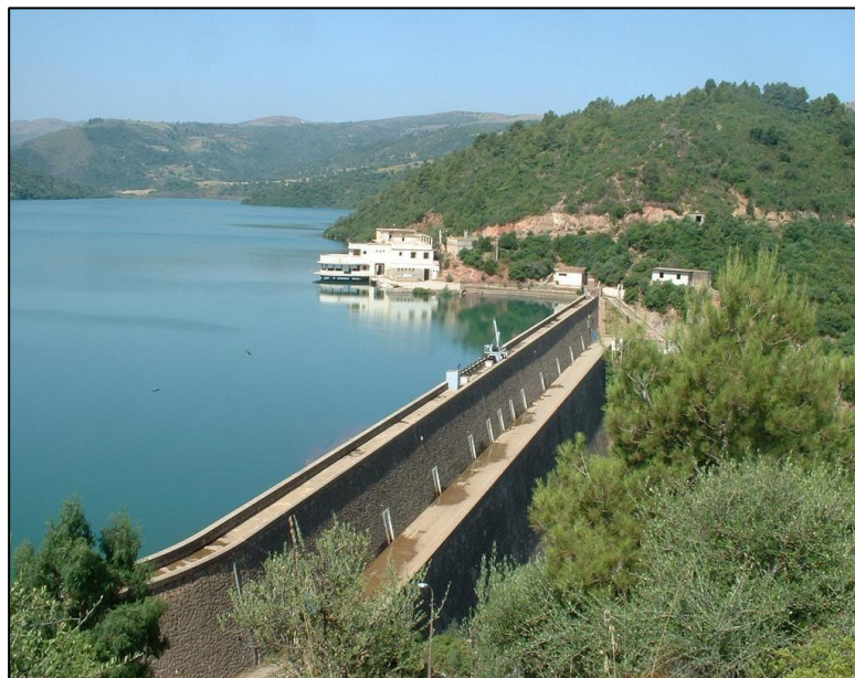
Figure II.9 : Barrage d'EL Hamiz (ANBT. 2019).
