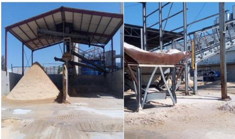
Figure I.7 : Traitement du sable (MFG)
