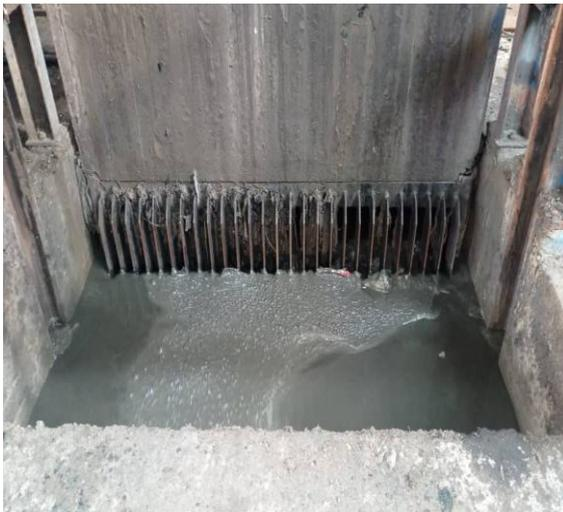
Figure n°14 Dégrilleur grossier (photo prise sur terrain Mars 2024).
