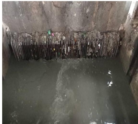
Figure n°15 Dégrilleur Fin (photo prise sur terrain Mars 2024).
