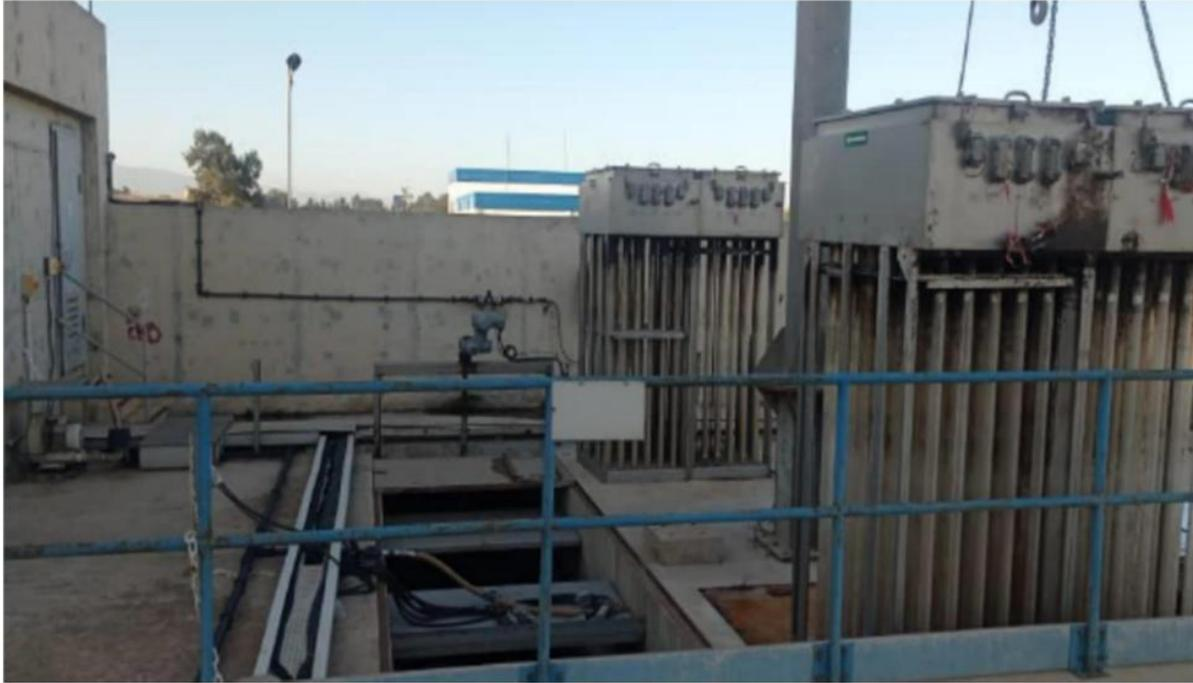
Figure n° 22 désinfection physique par UV (photo origine).
