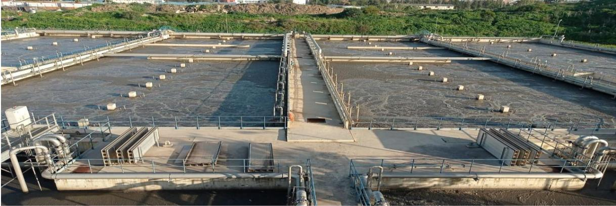
*Figure n°19 Bassin biologique ou d'aération (photo prise sur terrain Mars 2024).*
