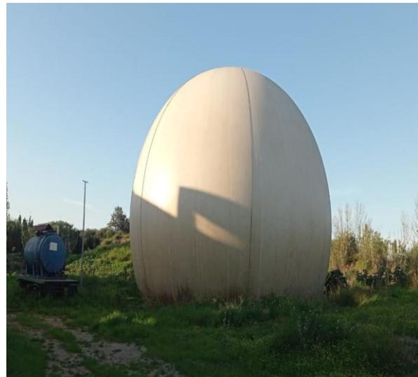
Figure n° 29 Gazomètre souple (photo prise sur terrain Mars 2024).
