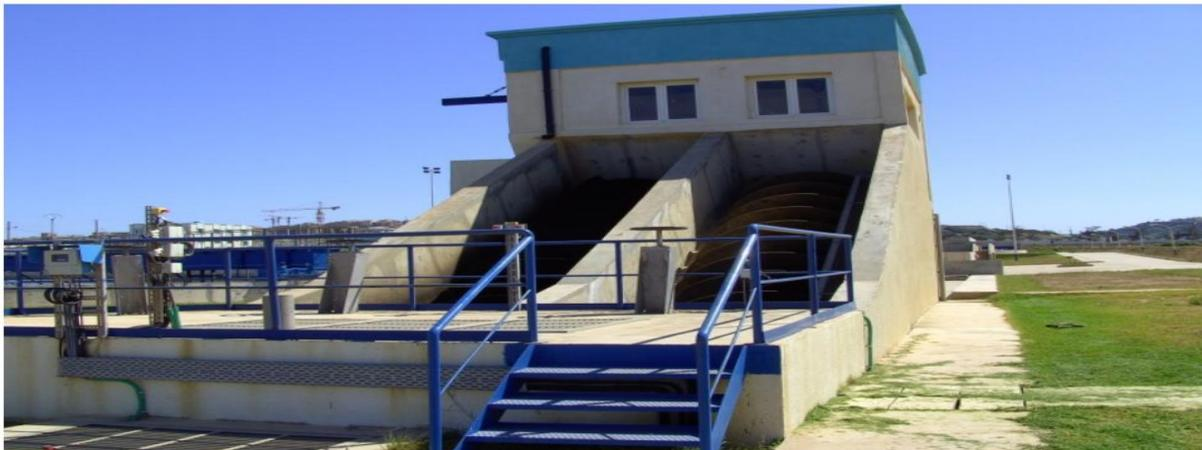
Figure n°23 Vis recirculation des boues (photo origine).
