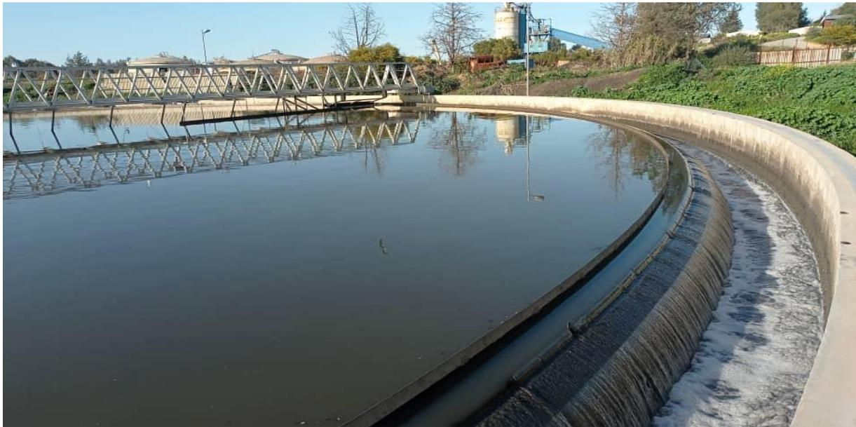
Figure n° 18 Décanteur primaire (photo prise sur terrain Mars 2024).
