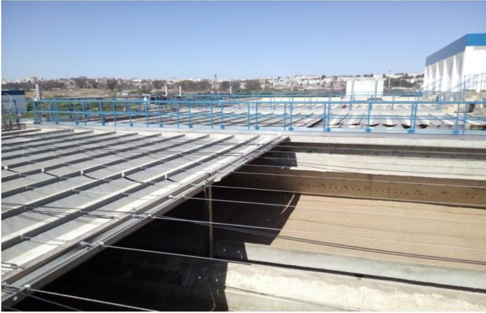
*Figure n°21 Filtre à sable (photo original).*
