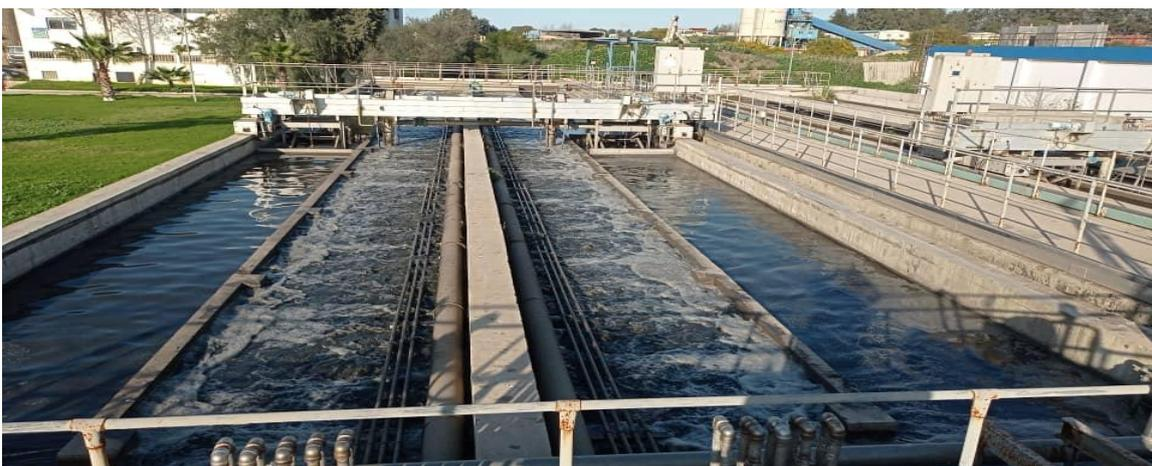
Figure n°17 Dessableur déshuileur (photo prise sur terrain Mars 2024).
