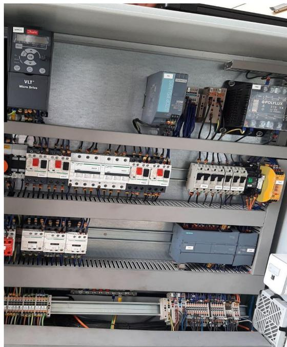
Figure 2.59 Armoire électrique.
