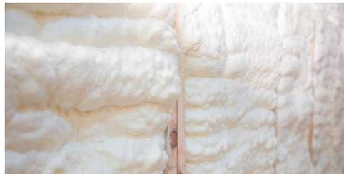
**Figure 1.4 :** Mousse Polyuréthane [4].
