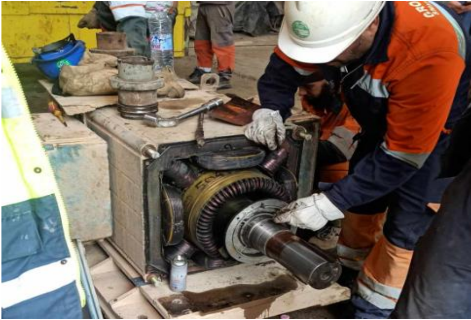
Figure 2-11 : maintenance de moteur
