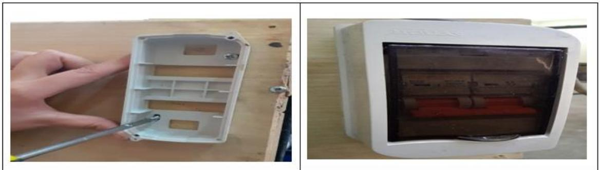
Figure IV. 8: l'installation de boîte disjoncteur
