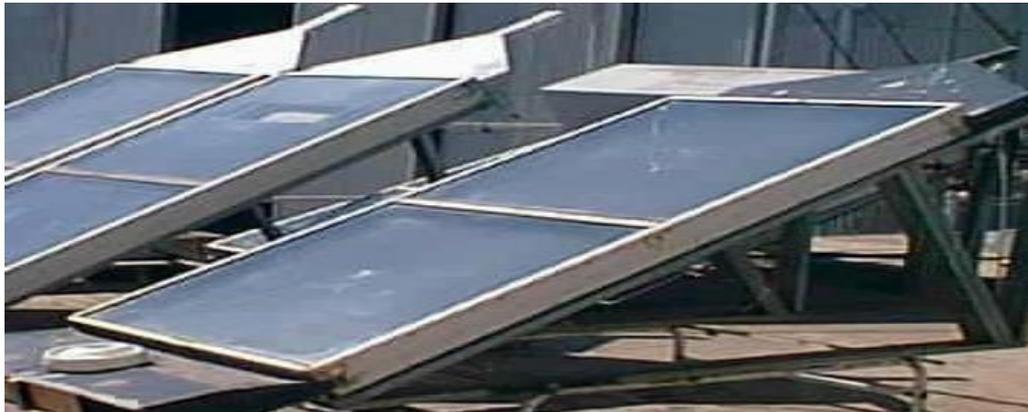
Figure (II – 1) : Capteur solaire a air [40]
