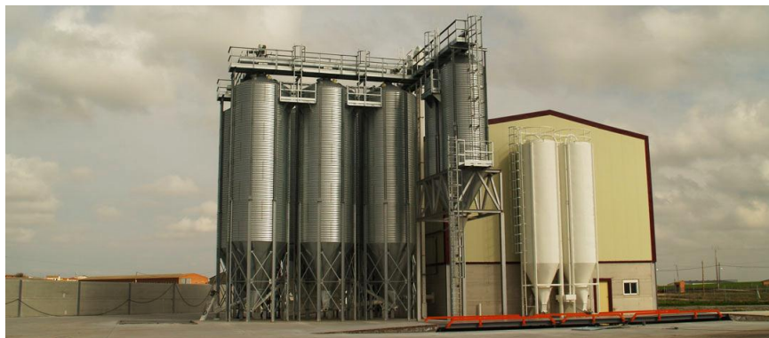
Figure I.9 : Stockage de matière première
