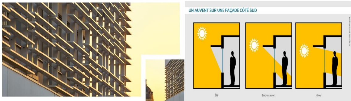
Figure 9.1: dispositif de contrôle solaire [57]
