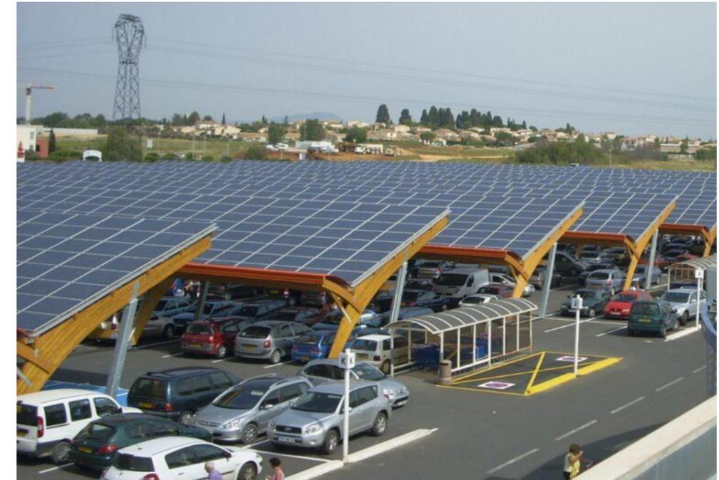
Figure 72 Panneaux photovoltaïques installés sur parking extérieur
