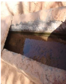
Figure 19 : Répartiteur d'eau principal Source INSID
