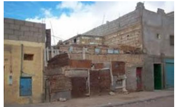
Figure 96: Les constructions « précaires » source : site lesarchivesdelaterrecuite.blogspot.com
