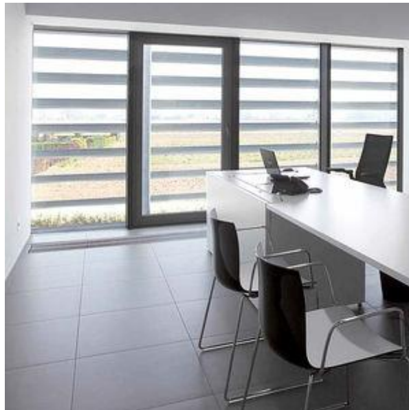
Figure 49 : Vue d'intérieur sur les Brises soleil orientables motorisés. Source : Brise-soleil orientable / Becher STP
