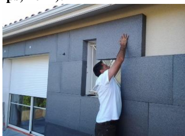
Figure 12. Système d'isolation thermique par l'extérieur. Source : https://azaneo.com/isolation-par-l-exterieur-avantages-techniques-et-etapes-de-realisation/
