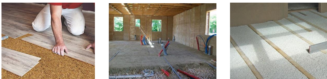
Figure 19. Des photos représentent les techniques d'isolations des plancher et des terrasses. Sources : https://www.rehabilitation-bati-ancien.fr/sites/creba/files/fichiers/2021/09/025_Recommandation_patrim_Ville_Grenoble.pdf
