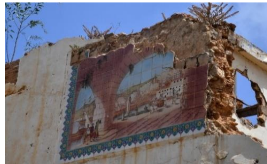
Figure 15. Les murs des bâtiments anciens. Source : https://www.middleeasteye.net/fr/rep-ortages/algerie-casbah-alger-patrimoine-res-tauration-ruines-unesco
