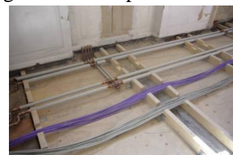
Nouvelle Tuyauterie et câbles sous le plancher
