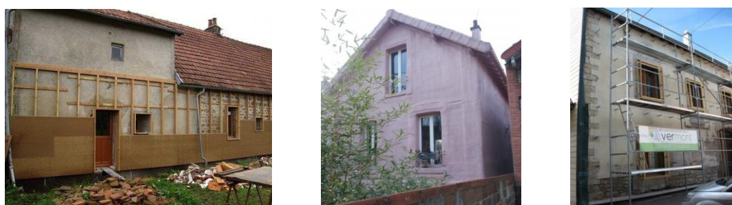
Figure 18. Les méthodes d'isolation des murs. Source : https://www.sitesetmonuments.org/loi-transition-energetique-demande-des-associations-en-matiere-d-isolation-par-l-exterieur-cmp
