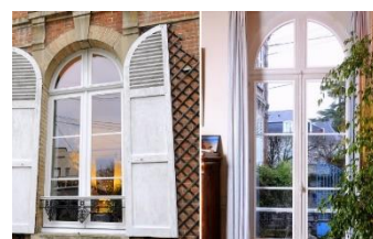
Figure 22. Le remplacement des vitrages avec la conservation de cadre. Source : https://www.svs-temed.fr/menuiserie-interieure/double-vitrage-renovation-sur-fenetre-bois-5066.html
