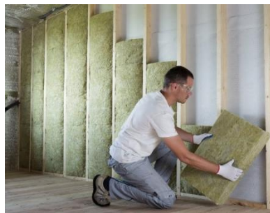
Figure 11. Système d'isolation thermique par l'intérieur. Source : https://ad-energie.com/services/isolation-des-murs-interieurs/
