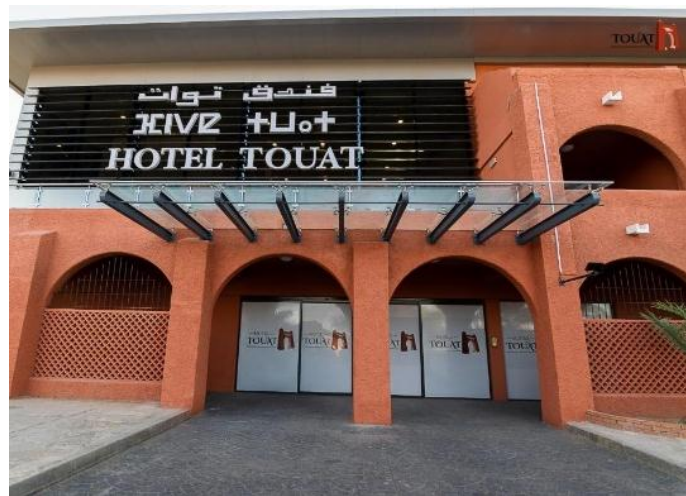
Figure 63 : Façade hôtel Touat a Adrar Source : Auteur 2024
