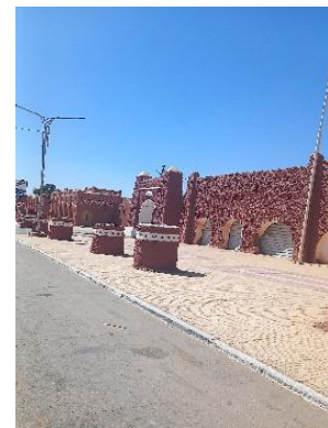
Figure 67 : Foggara sur la voie Source :auteur 2024
