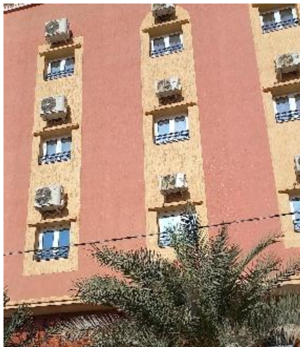
Figure 62 : Façade d'hôtel Hammad à Adrar Source : Auteur 2024
