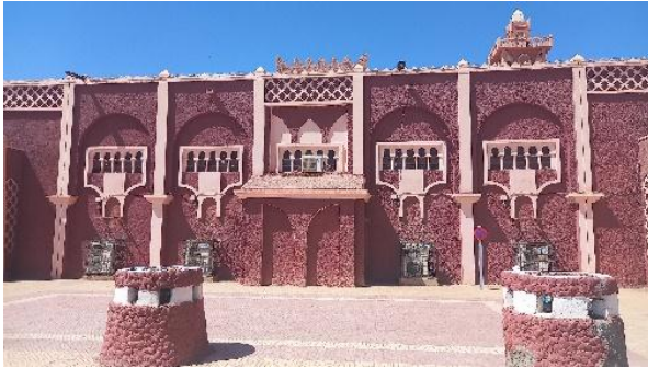
Figure 60 : Façade de la maison de culture à Adrar Source : Auteur 2024
