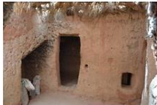
Figure 59 : Façade de Ksar d'Adrar Source : (Dr.Bachikh & Belbachir , 2021)
