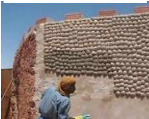
Figure 56 : Façade de Ksar d'Adrar Source : (Dr.Bachikh & Belbachir , 2021)
