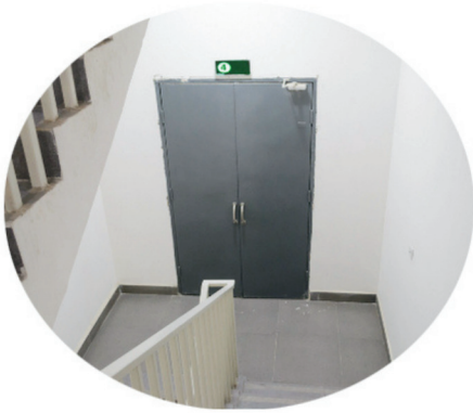
figure: La cage d'escalier
