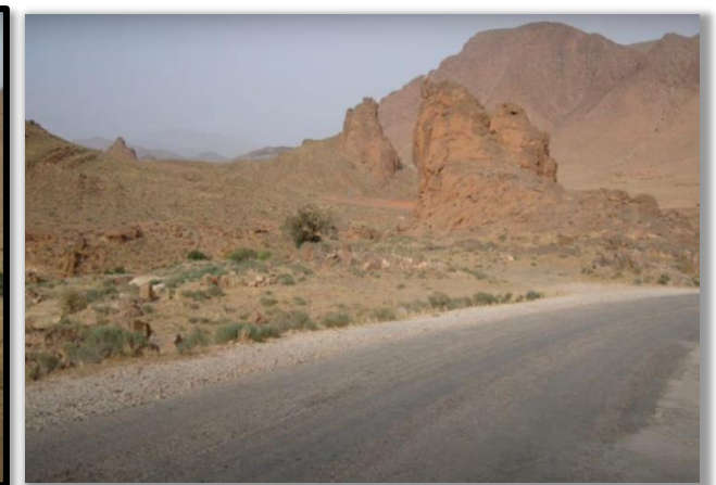
Figure 2. La voie principale CW.
