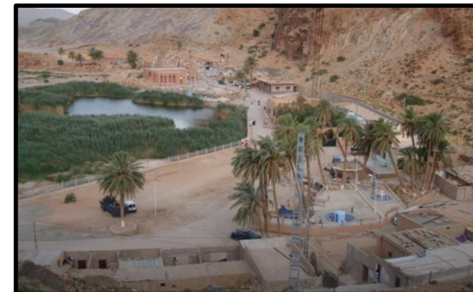
Figure 5. vue sur l'aire d'intervention.
