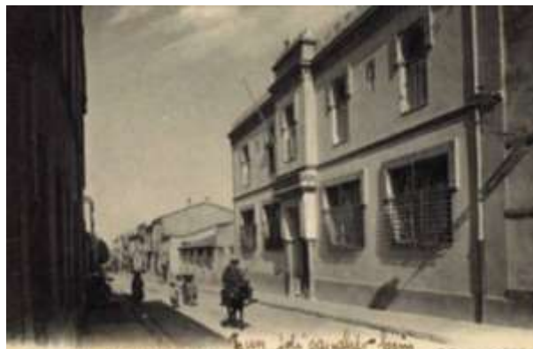
Figure 78: Lycée Ibn Rochd (Ex Duveyrier) Collège communal des garçons construit en 1883.
