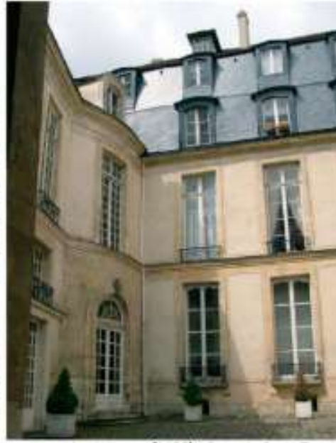
Hôtel Miboye (1650), 15 rue Vieille du Temple Réhabilitation avec démolition d'un immeuble laissé dans la cour
