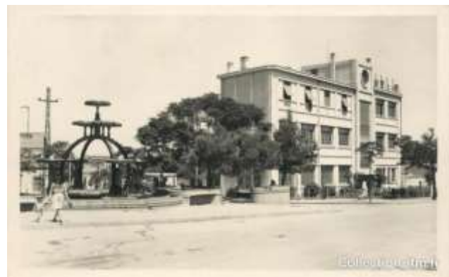
Figure 79 : Ecole Sidi Yekhlef (Ex Casnave) Construite en 1937
