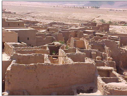
Figure 6 L'horizontalité et la compacité des constructions des ksours source : Mustapha Ameer Djeradi, L'ARCHITECTURE KSOURIENNE (ALGÉRIE) ENTRE SIGNES ET SIGNIFIANTS
