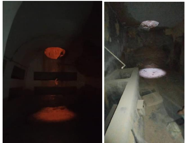
Figure 68 : Le sous-sol de l'hôpital Source: Hakem /Benkouidr 2024
