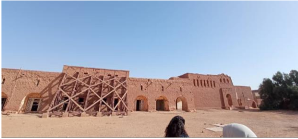
Figure 67 : La façade principale de l'hôpital source : Benkouide/Hakem 2024
