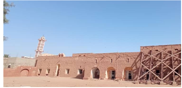
Figure 66: La façade principale de l'hôpital Source Benkouider/Hakem 2024
