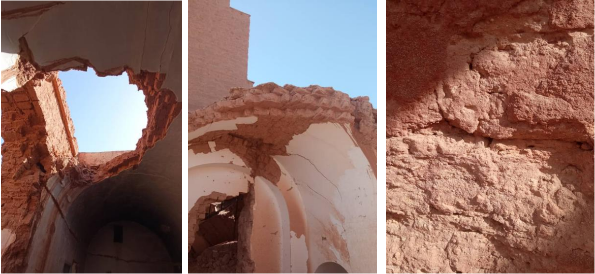
Figure 72: Les murs intérieurs de l'hôpital
