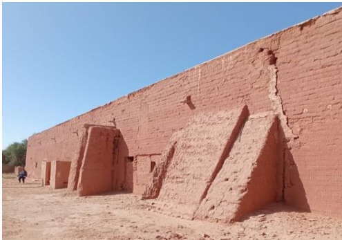
Figure 71 : L'utilisation des murs de soutènement Source : Benkouider /Hakem
