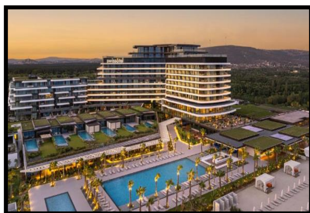
Figure 93: espace de loisirs
