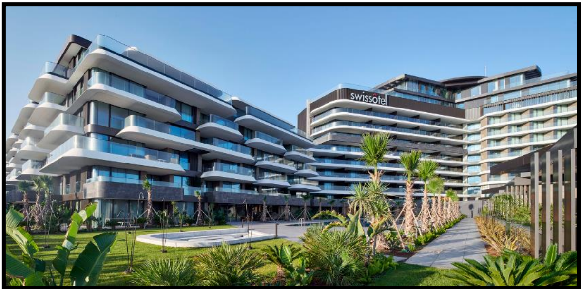
Figure 98: traitement de façade
