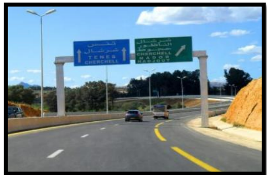
Figure 58: chemin de wilaya
