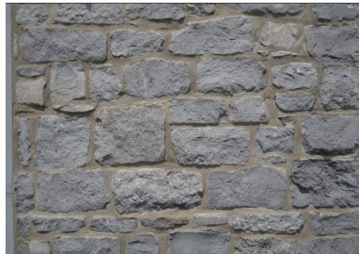
Figure10 : mur en moellon en pierre bleu sablé
