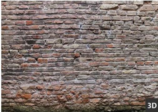
Figure9 ; mur en brique et enduit silex
