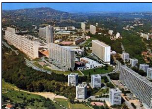
Figure 09 : vue aérienne du quartier la Duchère Lyon, 2002
