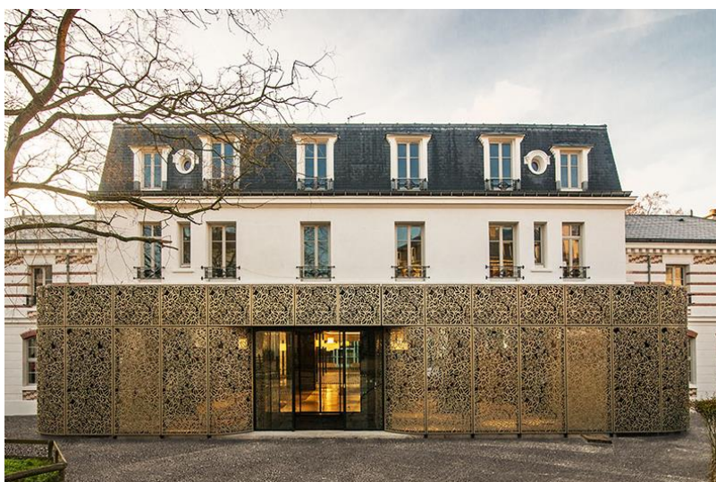
figure 4 : Rénovation et extension de la Médiathèque de Brunoy – 91000 Val d’Hyères
