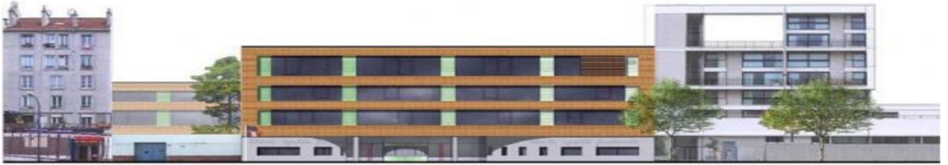
Figure 12 : la façade d'entrée de l'école saint exupery pantin/ source : www.batiactu.com
