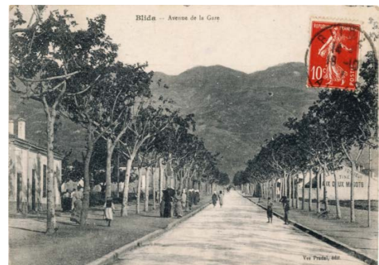
Figure 83: Avenue de la gare de Blida
