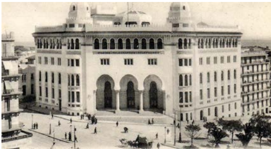
Figure 4: la grande poste d'Alger
