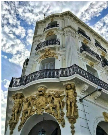
Figure 5: immeuble Haussmannien en Algérie:
