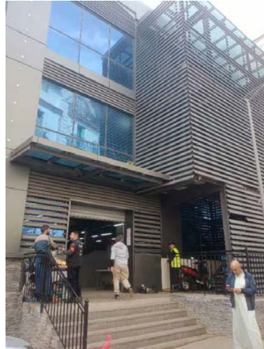
Figure 47: escalier de secours
