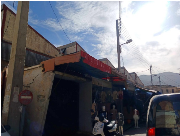
Figure 136: état de lieu de site
