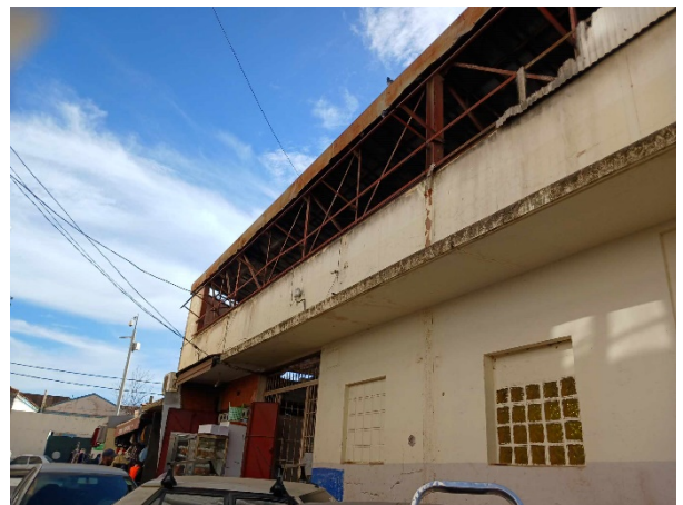
Figure 135: état de lieu de site
